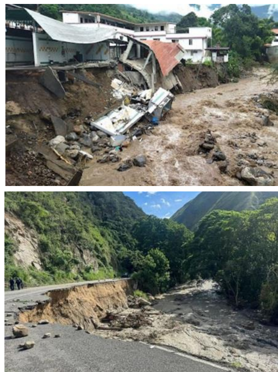
Figura 1. Vista de uno de los daños ocasionados en la parte alta y media de la cuenca por la crecida del río Chama. Fuente: https://youtu.be/AzJxYV-fRzc ; Diario Digital Tal Cual.
